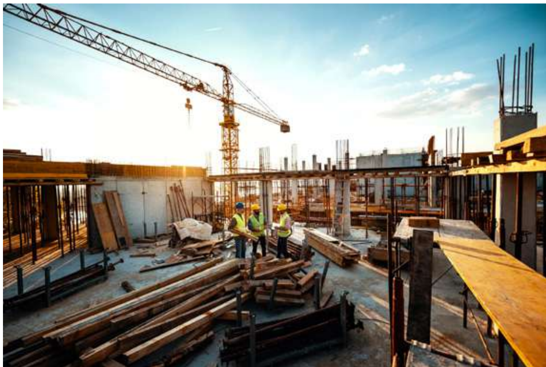
Trabalhos de construção civil e obras públicas Works by construction civil and works public
