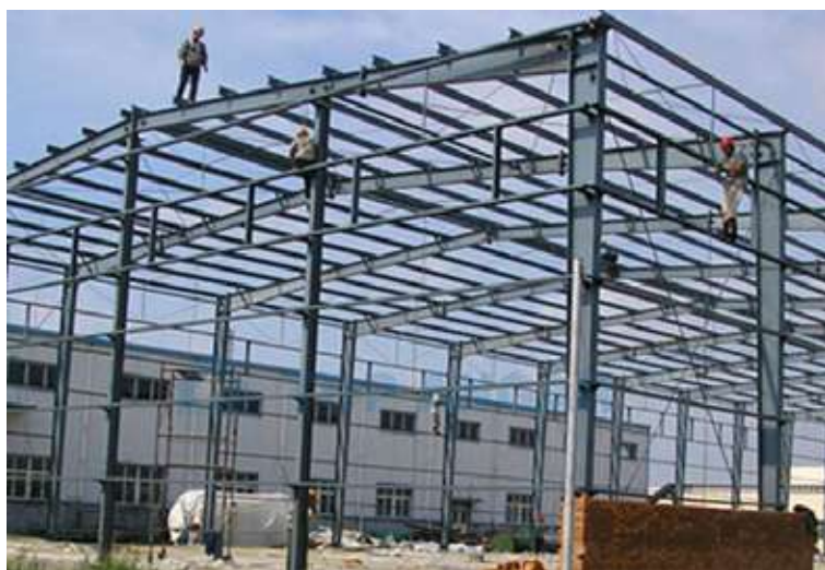
Construção de espaços com estrutura metálica Construction of spaces with metal structure
