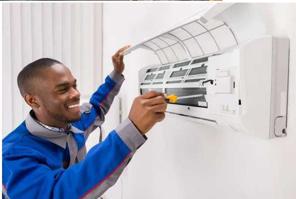
Montagem e manutenção de aparelhos de Ar Condicionado Assembly and maintenance of air appliances Conditioned
