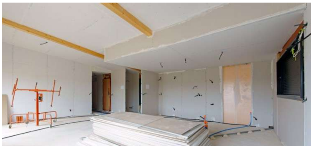
Divisória de escritórios e aplicação de teto falso Partition of offices and application of false ceiling
